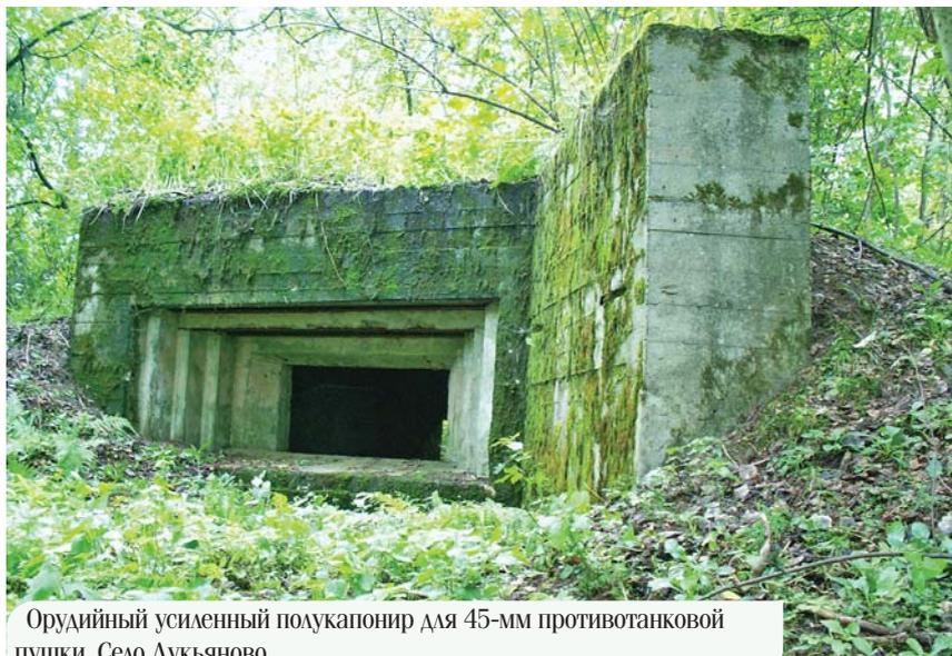
Орудийный усиленный полукапонир для 45-мм противотанковой пушки. Село Лукьяново
