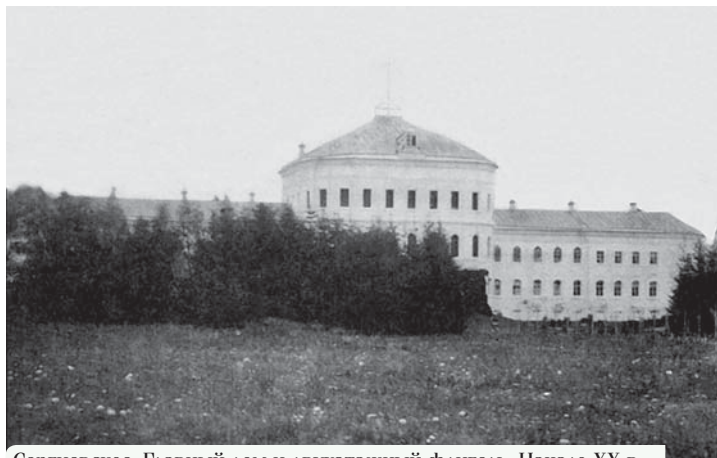
Сергиевское. Главный дом и двухэтажный флигель. Начало XX в.
