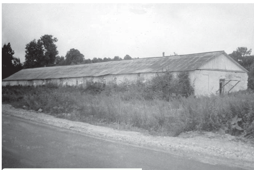
Амбар XIX в. Вид с северо-востока. 1980-е гг.
