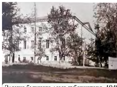
Здание бывшего дома губернатора. 1948 г.
