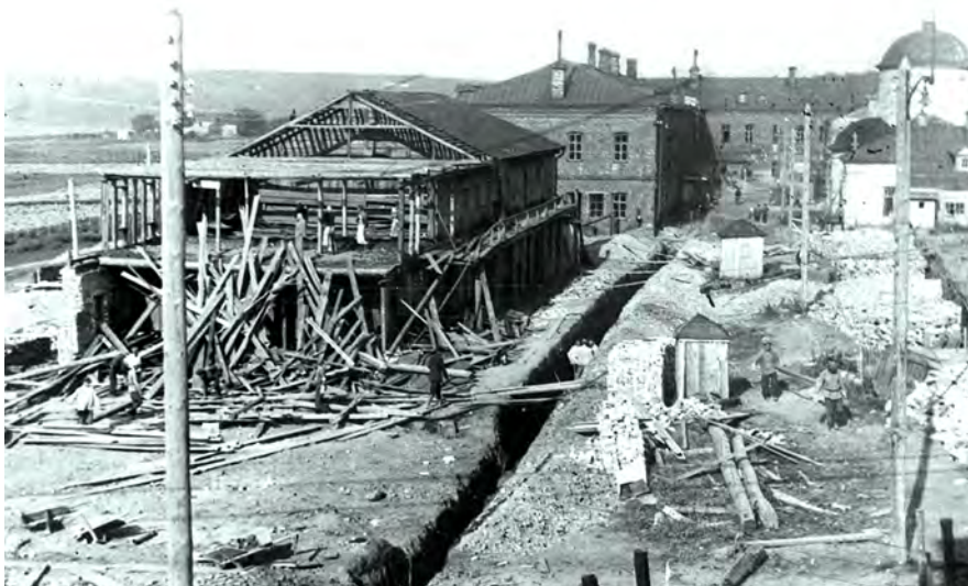
Строительство главного корпуса Калужского электромеханического завода (КЭМЗ). 1928 г.
