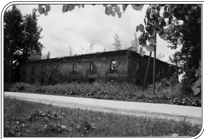
Городня. Хозяйственная постройка. 1996 г.
