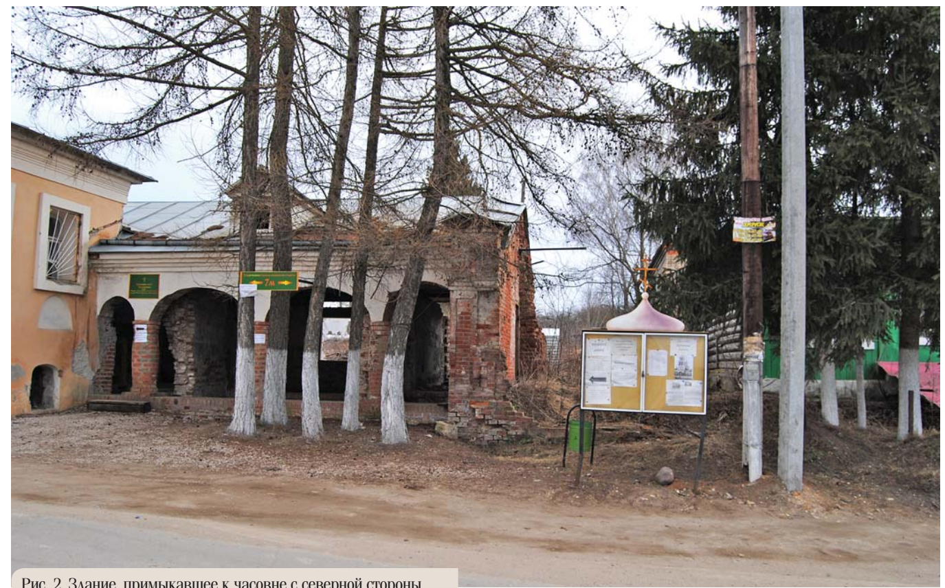
Рис. 2. Здание, примыкавшее к часовне с северной стороны
