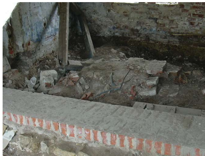
Рис. 3. Кирпичное основание, предположительно, под памятник в помещении, примыкавшем к часовне с северной стороны
