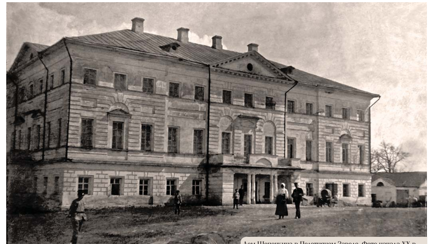
Дом Щепочкина в Полотняном Заводе. Фото начала XX в.
