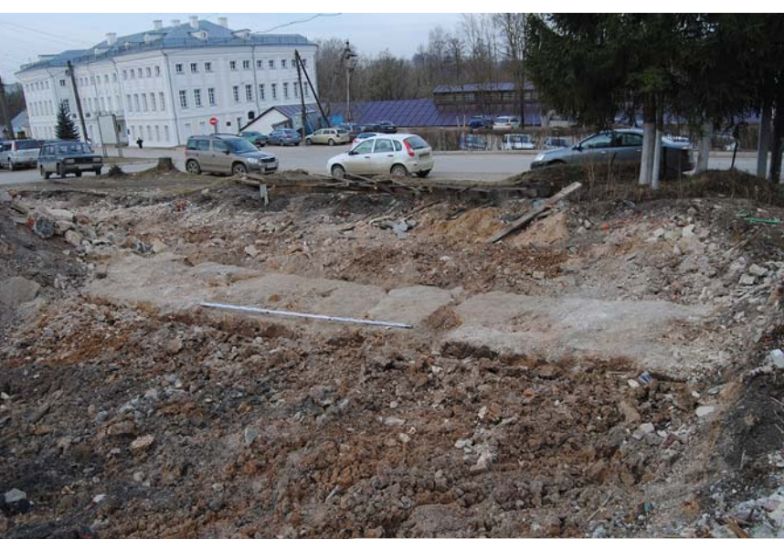
Рис. 9. Фрагмент основания западной стены
