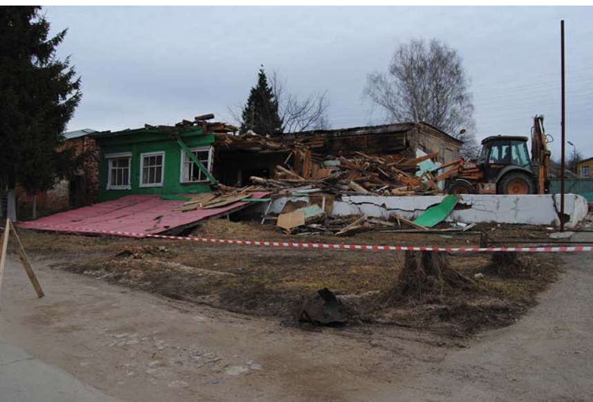
Рис. 7. Снос здания столовой
