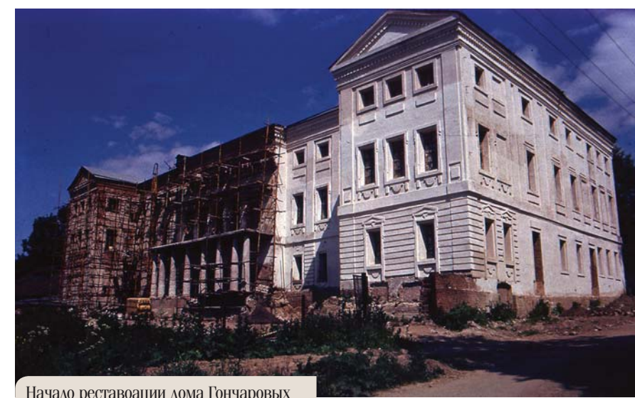
Начало реставрации дома Гончаровых
