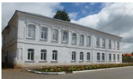
Усадьба городская XIX –нач. XX вв. Дом главный. (Н.Е.Журавлева). Ул. Луначарского, д.59
