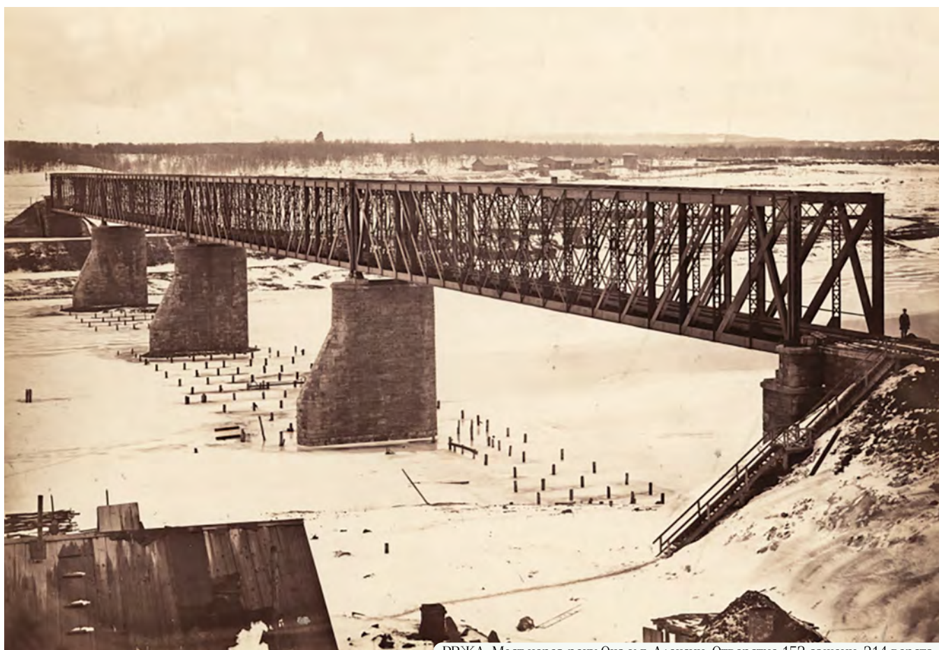
РВЖД. Мост через реку Ока у г. Алексин. Отверстие 153 сажени, 214 верста
