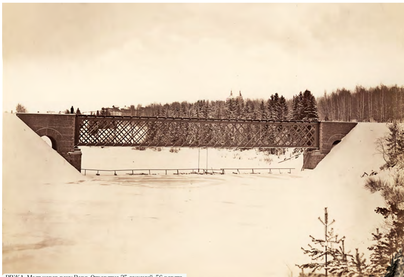
РВЖД. Мост через реку Воря. Отверстие 25 сажений, 56 верста
