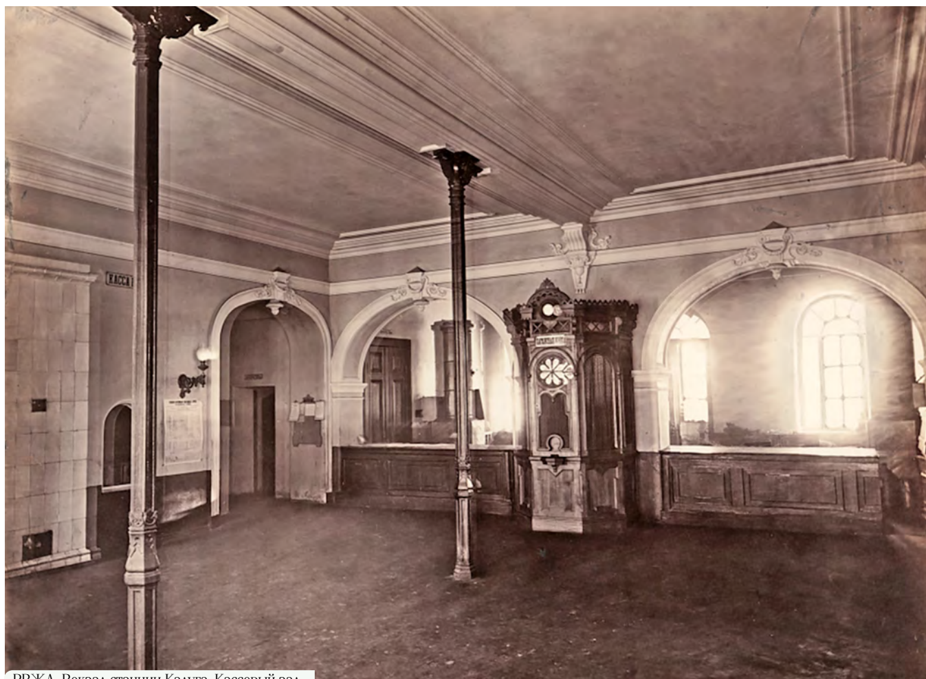
РВЖД. Вокзал станции Калуга. Кассовый зал
