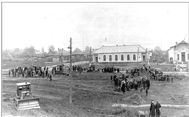
Строительство нового здания библиотеки (1957 г)
