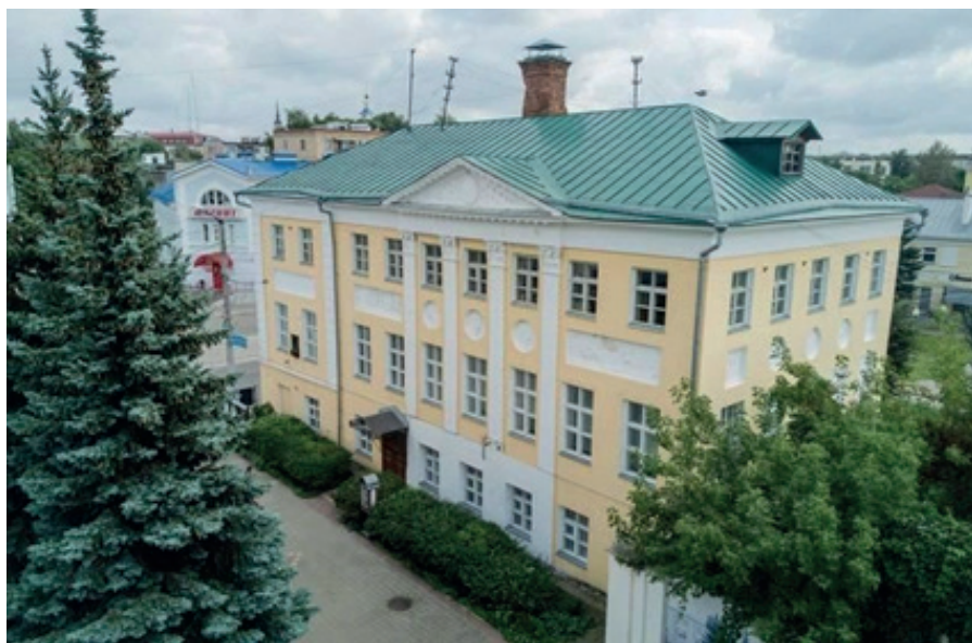
Дом Билибиных на Одигитриевской улице (ныне Дом Шамиля на улице Пушкина)
